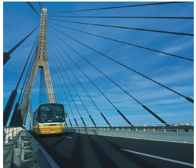
Γέφυρα που συνδέει την Ισπανία και την Πορτογαλία στον ποταμό Γκουαντιάνα, Αλκάρβε, Πορτογαλία
