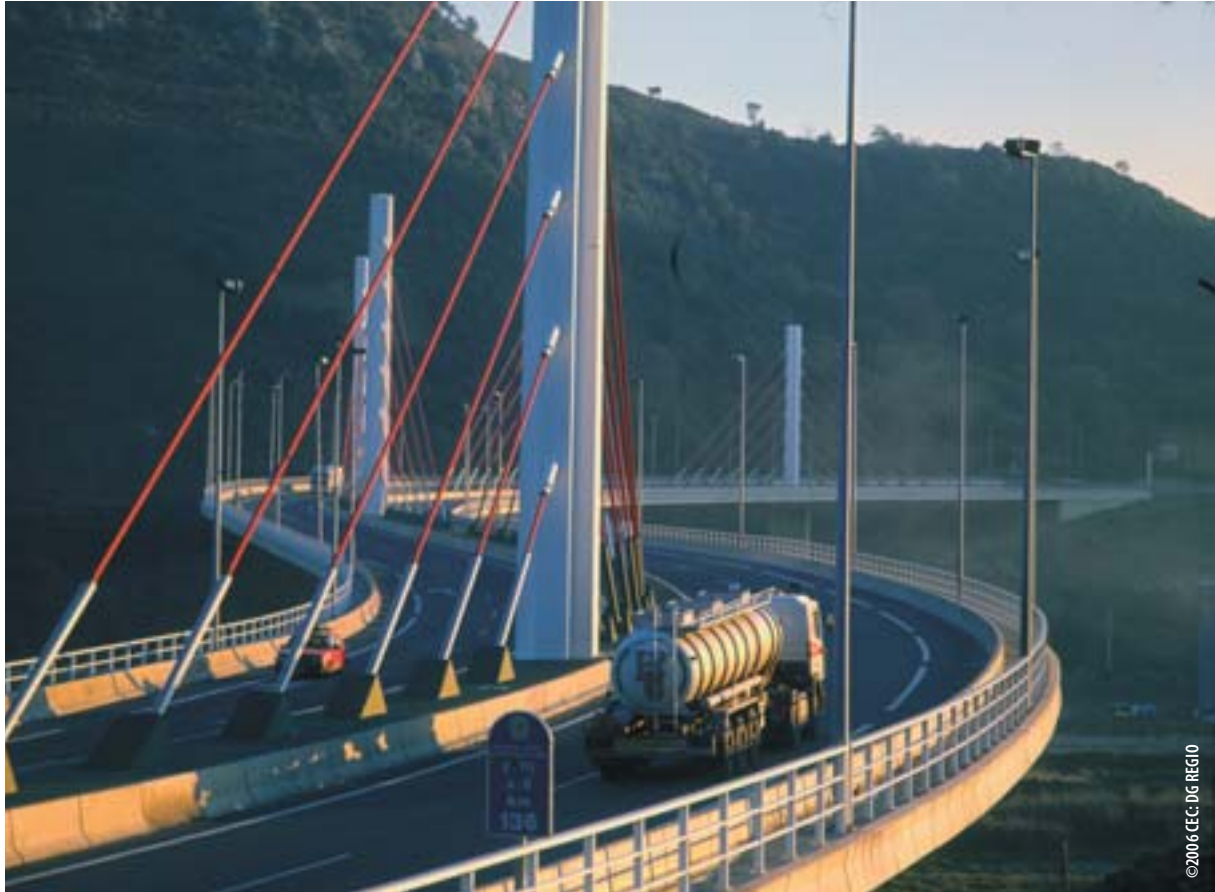
Γέφυρα στο νέο αυτοκινητόδρομο Bilbao - Santander, κοντά στο Las Arenas, Χώρα των Βάσκων (Ισπανία)
