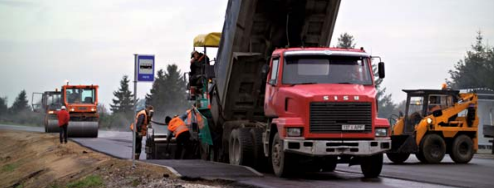
Νέο οδικό δίκτυο στην Εσθονία: ο αυτοκινητόδρομος Via Baltica
