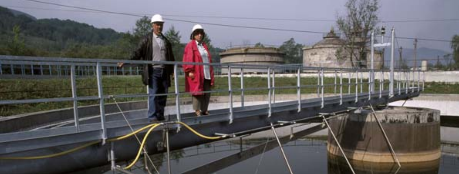
Η νέα μονάδα επεξεργασίας ύδατος του Danutoni κοντά στο Petrosani, Ρουμανία
