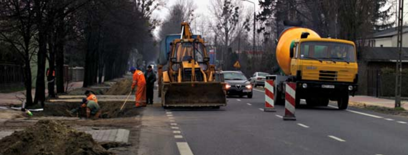
Εργοτάξιο οδοποιίας, Πολωνία
